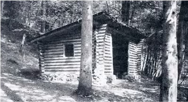
Abb.21 – Vom VVK 1966 erstellte Schutzhütte
